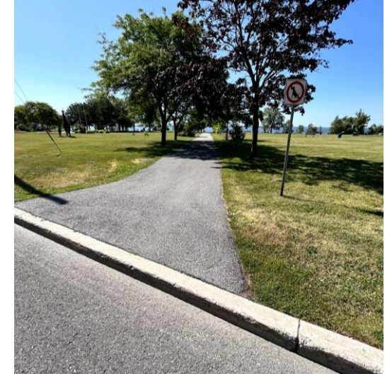
Absence d'abaissée de trottoir (parc Pine Beach). Source : AECOM
