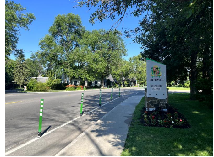
Bande cyclable sur le chemin du Bord-du-Lac-Lakeshore. Source : AECOM
