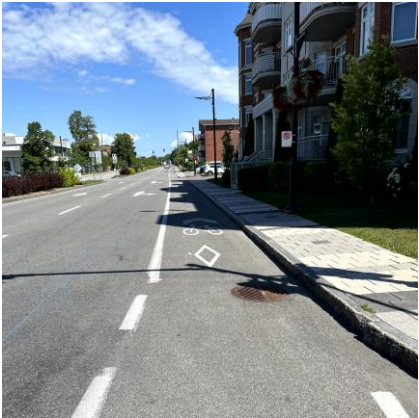
Bande cyclable sur l'avenue Dorval. Source : AECOM
