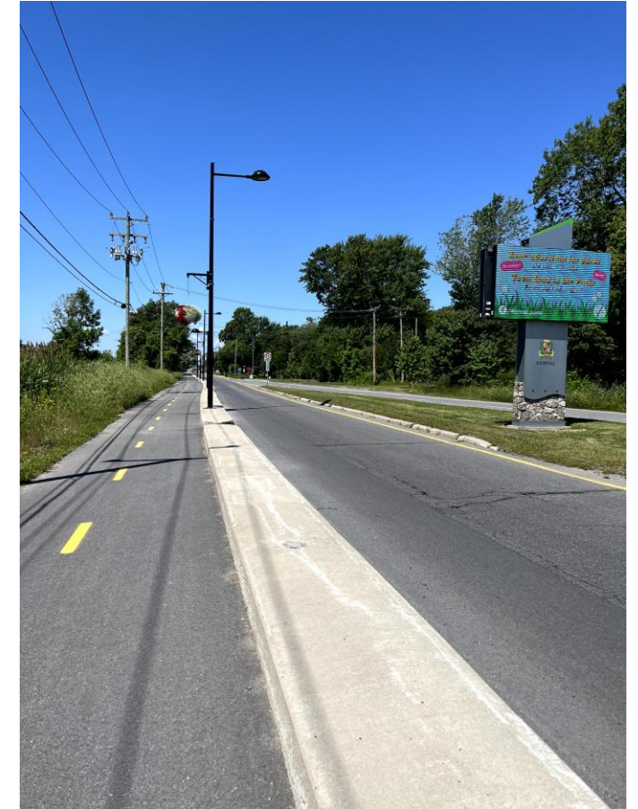
Piste cyclable sur l'avenue Cardinal. Source : AECOM
