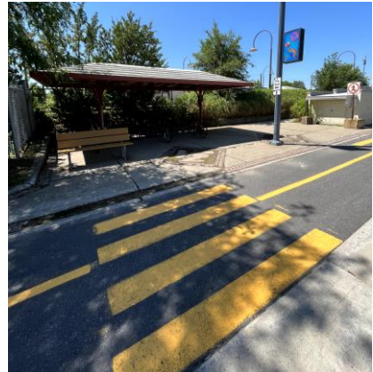
Piste cyclable sur l'avenue Cardinal. Source : AECOM
