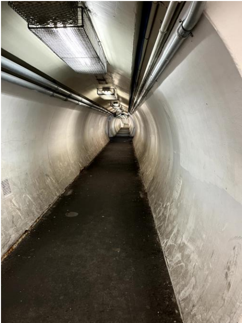
Tunnel à la gare Pine-Beach. Source : AECOM
