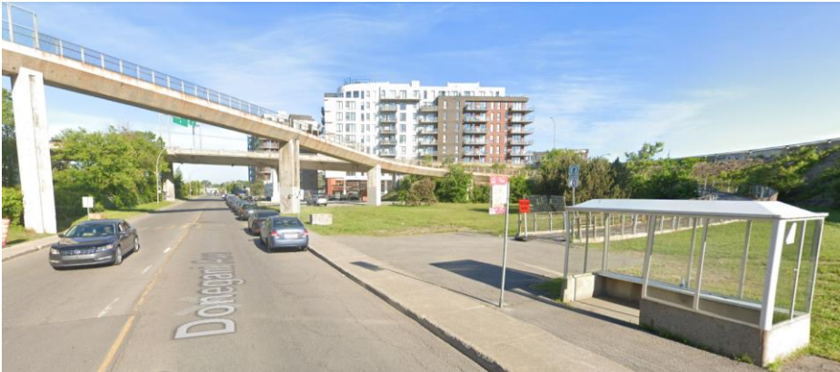
Accès nord à la passerelle. Source : Google 2022
