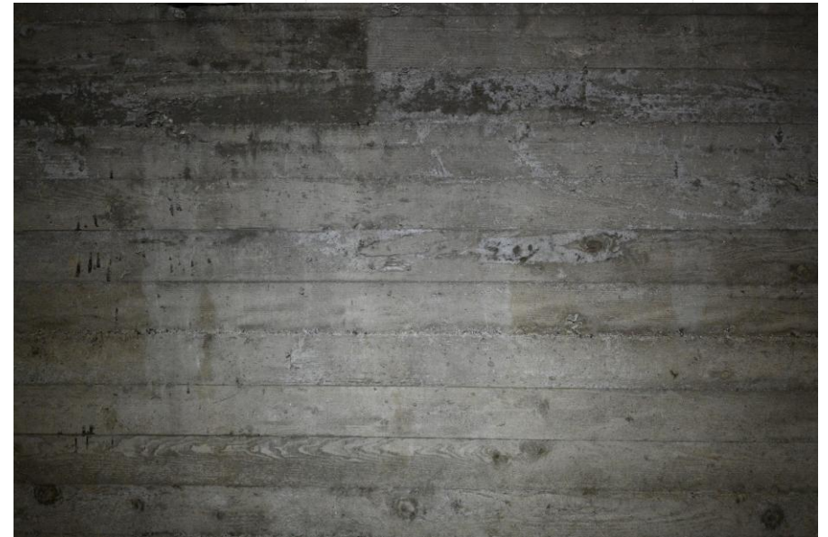
Finition en béton brut
