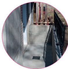
Après travaux - aménagement muret et escaliers d'accès
