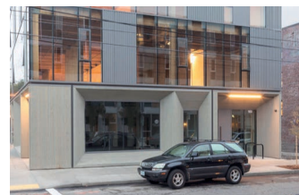
2 Ex. surélévation de mur-rideau
