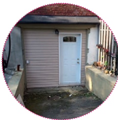
Avant travaux - entrée en conte-pente
