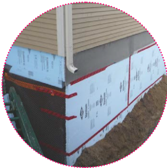
Exemple d'isolation extérieure de murs de fondation.
